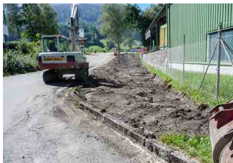
Für die provisorische Zufahrt wurde der Humus abgetragen.
