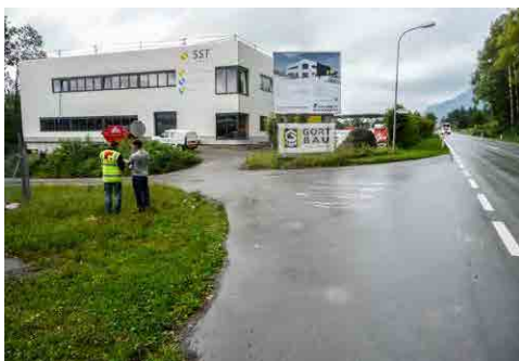
Diese Kreuzung muss um ca. 1 m angehoben werden.
