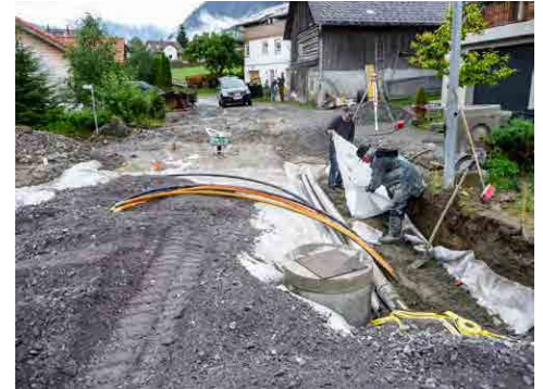
Leerrohre für den Breitbandnetzausbau der E-Werke Frastanz und der A1-Telekom.
