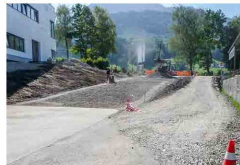
Rechts die provisorische Zufahrt, links der angehobene Kreuzungsbereich.
