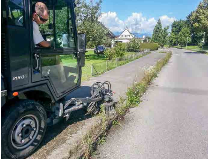
Es braucht einen massiven Stahldrahtbesen um die Fugen freizufegen.
