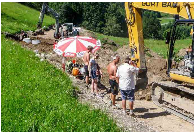
Kanalarbeiten unterhalb von Muggabill. Im Schatten eines Sonnenschirms werden die PP-Rohre endlos verschweißt. Eine Vorsichtsmaßnahme im Quellschutzgebiet.
