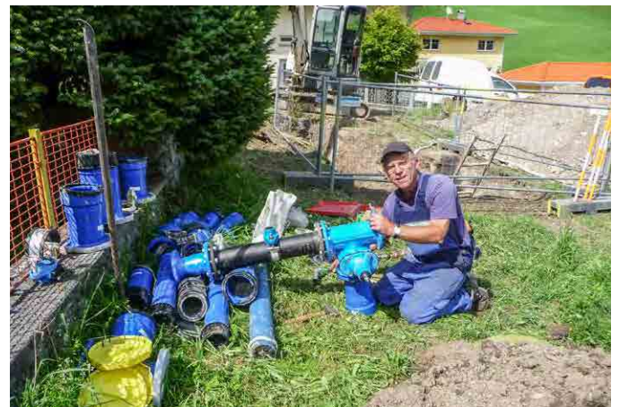
Ein Wasserverteilungsknoten wird von Wassermeister Herbert Schallert zusammengebaut. Beim Einbau musste die Wasserversorgung kurz unterbrochen werden.
