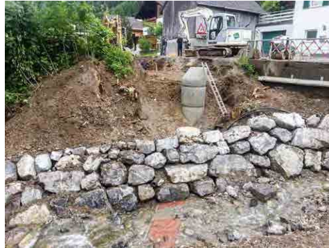
Der Rofelbach wurde unterquert. Die Rohre wurden mit einer Stahlplatte vor dem Geschiebeabrieb geschützt.
