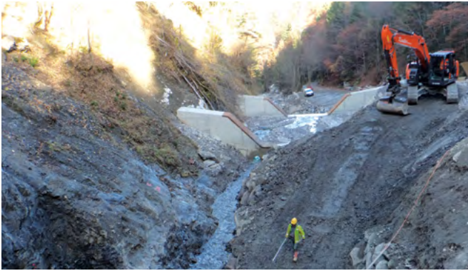
Die neu errichteten Talsperren in der Galina
