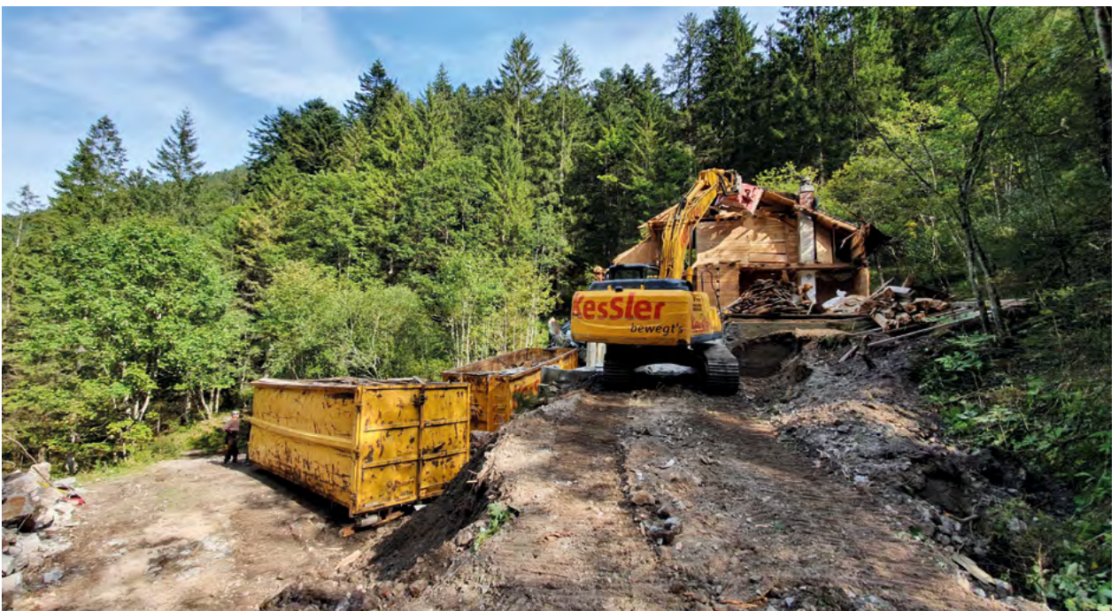
Das bestehende Wildbach-Gebäude wird abgetragen.
