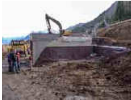
Der Rohbau des Hochbehälters steht. Im Frühjahr wird mit den Installationen begonnen.
