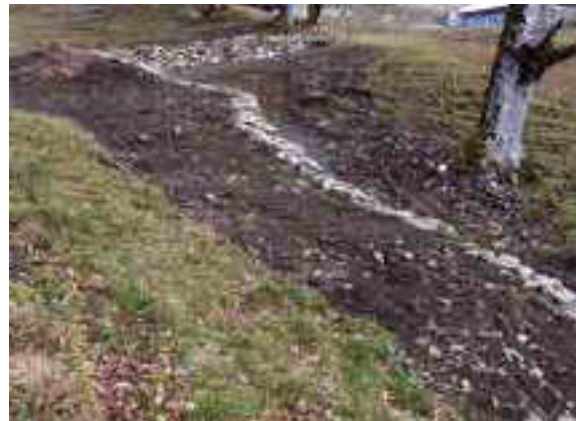
Die Mauer wurde mit vorhandenen Steinen neu aufgebaut.
