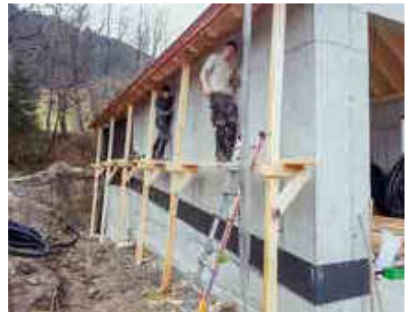
Das Gerüst für die Fassadenschalung steht.
