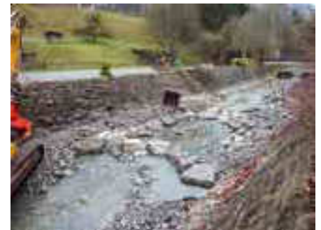
Die hohen Stufen wurden in Teilabschnitte aufgelöst. Die Bogenform erhöht die Stabilität.
