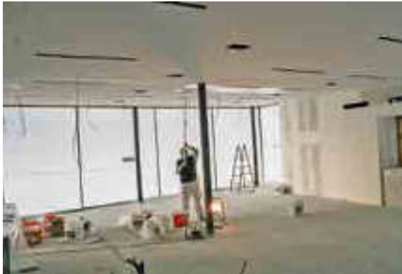
Die Malerarbeiten stehen kurz vor der Fertigstellung.
