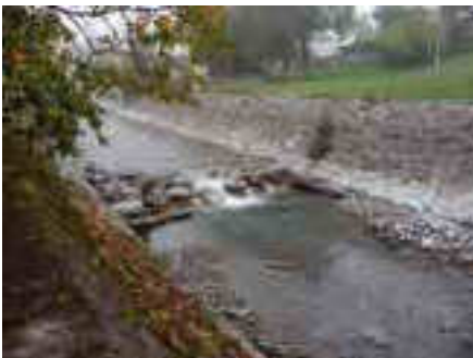
Die Kolkshäden seitlich sind deutlich zu sehen.
