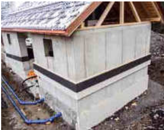
Das Dach ist errichtet, die ersten Leitungen wurden verlegt.
