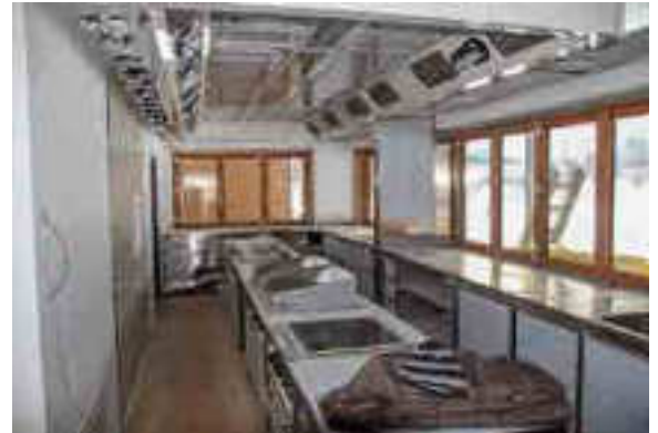
Die Küche wurde bereits eingebaut.
