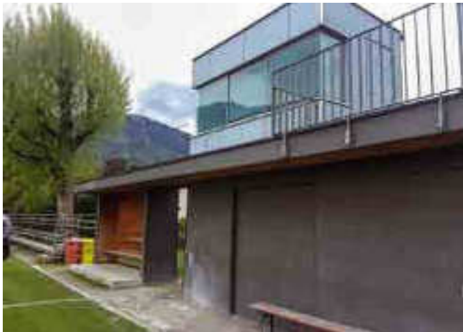
Der Sprecherturm beim alten Sportplatz wird abgebaut und beim neuen Sportplatz wieder aufgestellt.
