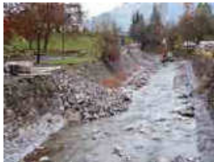
Auf dieser Rampe gelangt der Bagger ins Bachbett.
