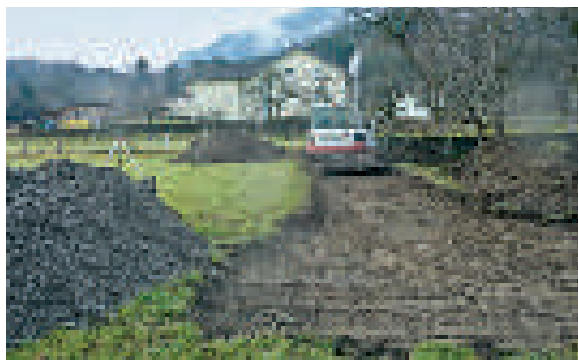
Die erste Arbeit beim Kanalbau – Humus seitlich lagern Anschließend geht es richtig in die Tiefe.
