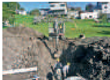
Der hinterste Hausanschluss in der Mengschlucht wird gegraben.
