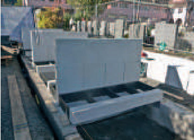
Die Grabplatten und die Beetbalken werden auf die Fundamente gesetzt.
