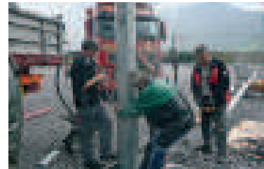
Die Flutlichtmasten werden gestellt.
