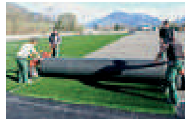
Mit einem Spezialwagen werden die Kunstrasenbahnen ausgerollt.
