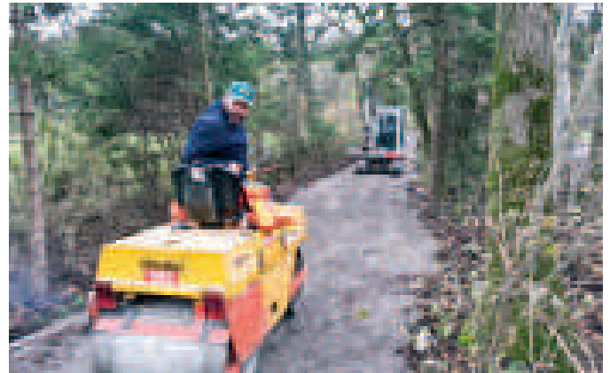
Bauhofmitarbeiter Manfred Latzer verdichtet den Schotter aus der Galina.
