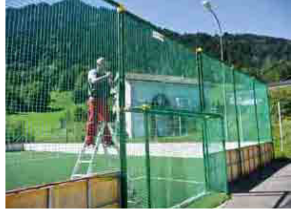
Die neuen Netze werden aufgehängt.
