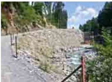
Die Rückseite der Geschiebesperre
