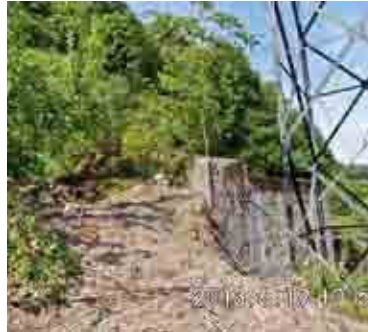
Jahrzehntelang stand dieser Starkstrommast hinter dem Schutze dieser Betonmauer.
