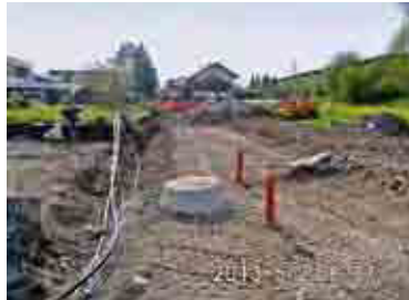
Kanal- und Wasserleitung sind verlegt. Anschließend wurden die Kabel verlegt.
