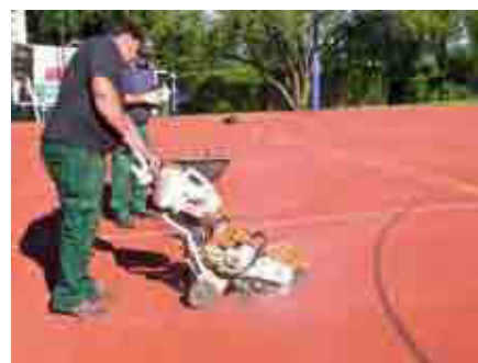
Die Sanierungskanten werden geschnitten.
