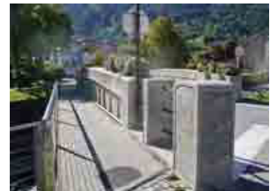
Der Beton ist jetzt wieder sauber. Wieder ein schönes Stück Nenzinger Geschichte.
