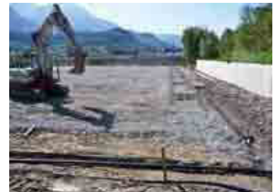
Der Kunstrasenplatz erhält einen Unterbau ähnlich einer Straße.
