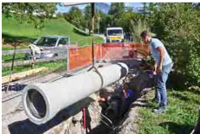
Bauführer Alfons Sperger überwacht das Setzen des ersten Rohres persönlich.
