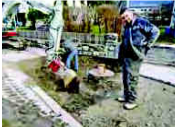
Polier Didi. Der Anschlusschacht wird freigelegt.
