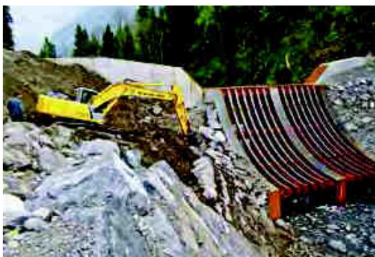
Letzte Böschungssicherungen
