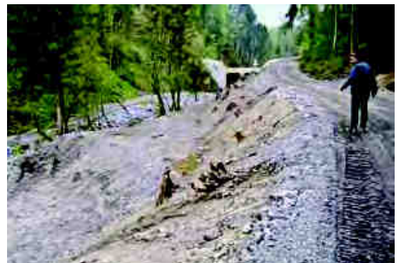
Der neue Überfahrtsweg über die Geschiebesperre
