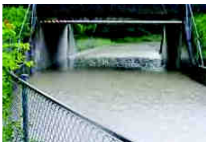
Unterführung „Bettler Äule“
