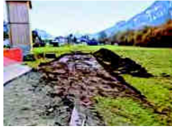
Die Leitungstrasse wird abhumusiert.
