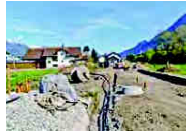
Alle erforderlichen Leitungen und Kabel werden verlegt.
