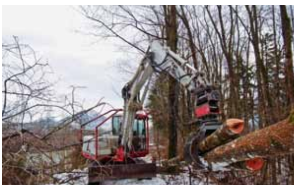
JlIdamm-Rodung durch den Wasserverband Jll - Walgau
