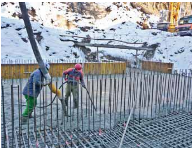
Die Fundamentplatte wird betoniert
