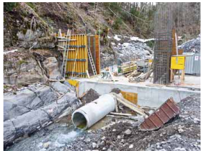
Auf der Fundamentplatte werden die Seitenwände aufgesetzt.
