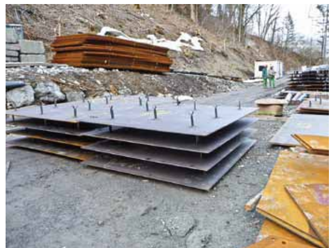
Auf der Fundamentplatte werden die Seitenwände aufgesetzt.
