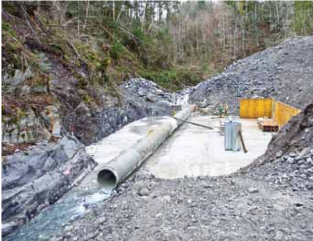
Sauberkeitsschicht mit provisorischer Mengüberleitung
