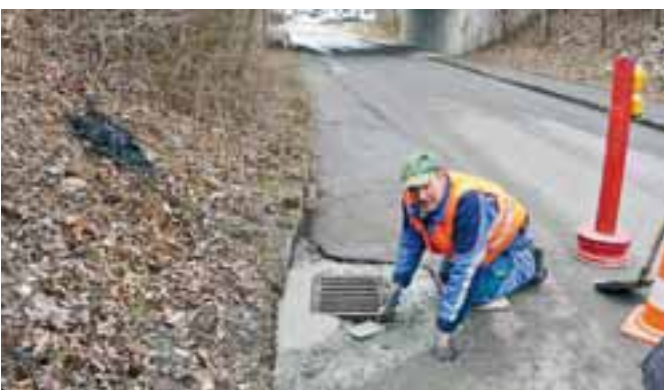
Herbert saniert ein abgesacktes Straßeneinlaufgitter
