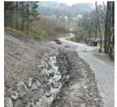
Überleitung Barschliefbach zum Tuxbach
