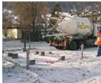
Der erste Silo, voll mit Splitt, wird angeliefert.
