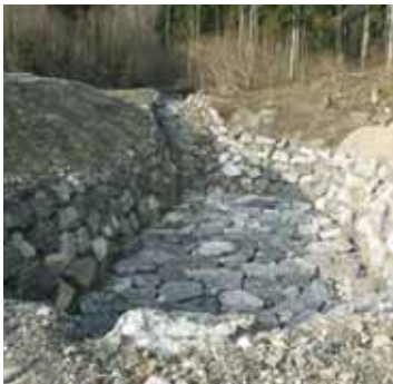
Schotterfang oberhalb des Campingplatzes
