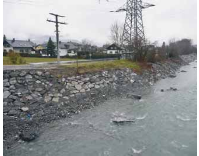
Die fertige Arbeit, mit Störsteinen für die Forellen.
