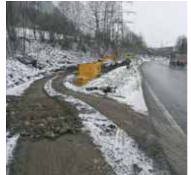
Die Baustelle im Bereich der Einfahrt zur Firma Liebherr im Überblick.
