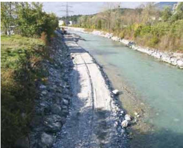
Über die provisorische Baustraße erfolgt die Steinanlieferung.
