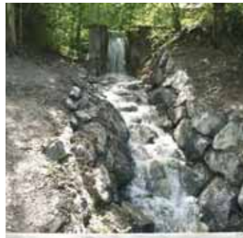
Ablauf aus Kiesfang im Ortsbereich Beschling erneuert
