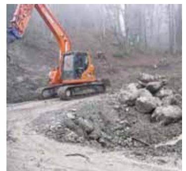
Schotterfang Tschardund im Bau
