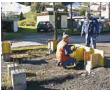
Herbert und Manfred erhöhen die Silofundamente.
