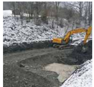
Beckenaushub. Deutlich sichtbar der Grundwasserstand
