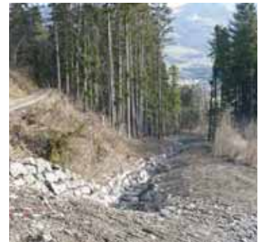
Gerinneausbau neben dem Campingplatz
