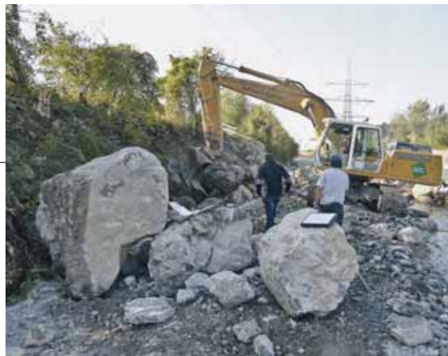
Die Vorgrundsteine bilden das Fundament.
