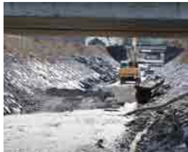
Die Wasserbausteine werden über die Böschung gekippt
