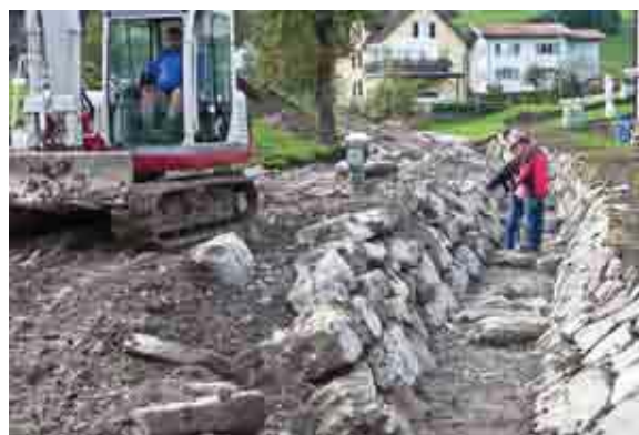
Steinverlegung genau nach Plan
