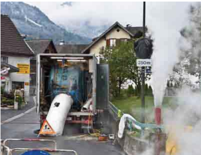
Ein Dichtschauch wird in den Kanal eingezogen
