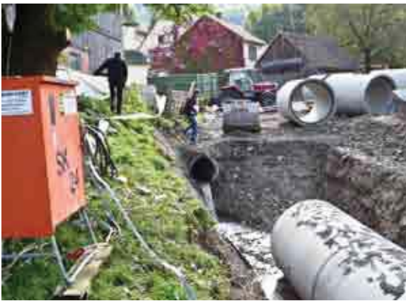
Neues Rohr trifft auf altes Rohr
