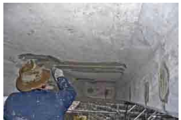
Verschließen der ausgespitzten Sanierungsstellen mit Spezialmörtel
