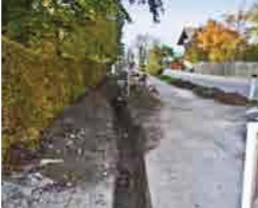
Der Graben für das Kabel wird gezogen
