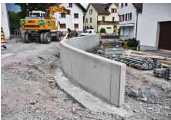
Die größte Mauer im Baulos
