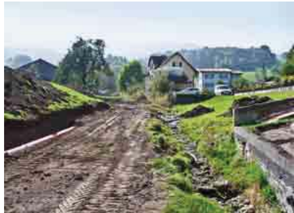
Rechts das ursprüngliche Bachgerinne, links die Baustraße
