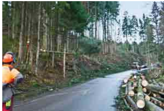
Blick von der Zufahrt zum Campingplatz auf die Trasse des Hochwasserentlastungsgerinnes
