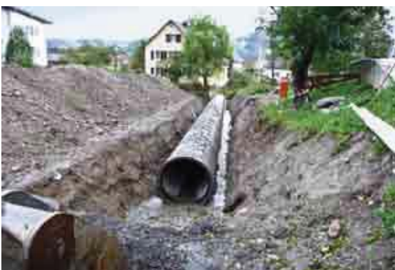
Leider musste ein Teil verrohrt werden
