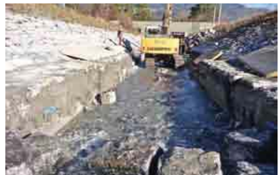
Deutlich zu sehen, wie dick das Sohlpflaster wird
