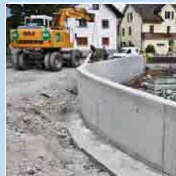
Seite 5 Ausbauarbeiten Bazulstraße sind abgeschlossen
