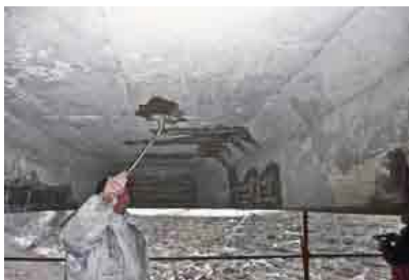
Aufbringen des Rostschutzes und Haftgrundes
