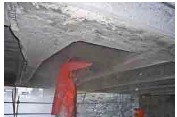
Sandstrahlen der Bewehrung bis sie blank ist
