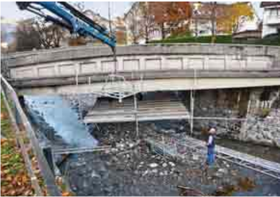
Das Arbeitsgerüst wird an der Brücke aufgehängt
