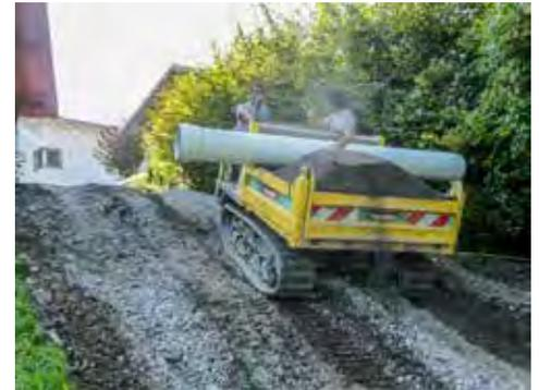
Kanalrohre und Ummantelungskies werden zur Baustelle transportiert.
