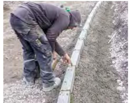
Die Fugen werden satt mit Mörtel geschlossen.
