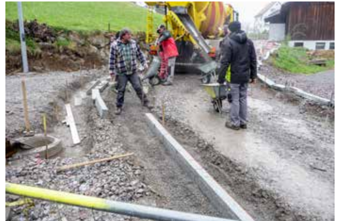
Beidseitig geschnittene Randsteine trennen den Gehbereich von der Fahrbahn.
