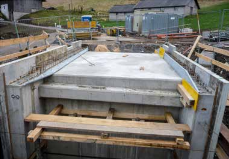
Die Details sind wie bei einer großen Brücke ausgeführt.
