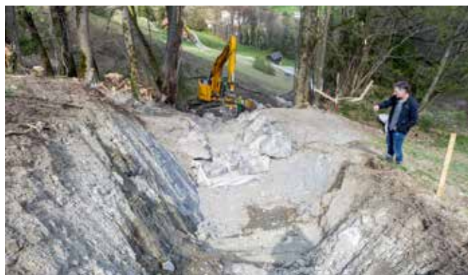
Bauleiter DI Martin Jenni von der WLW begutachtet das ausgebaute Gerinne.
