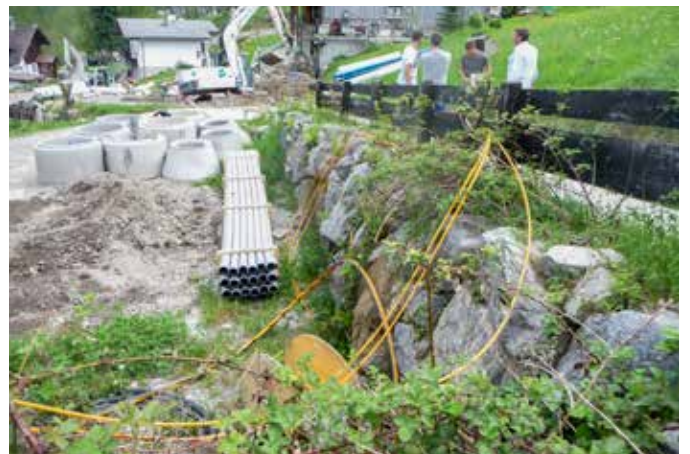
„Im Loch“ ist es steil und eng. Für die Kanalisierungsarbeiten sind dies keine idealen Voraussetzungen.
