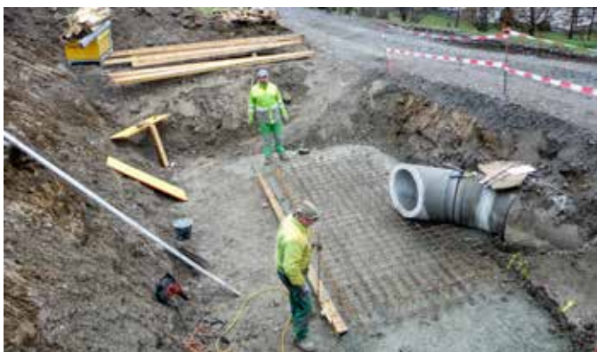
Die Bodenplatte für den Einlaufschacht wird vorbereitet.
