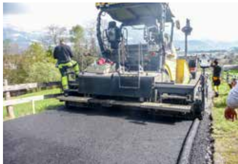
Eine Asphaltwulst am Straßenrand leitet das Regenwasser bis zum nächsten Einlaufschacht.
