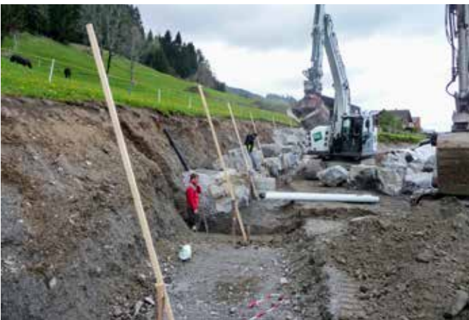
Steile Straßenböschungen werden mit einer Trockenmauer gesichert.
