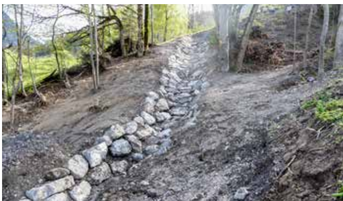
Nach der Verrohrung läuft das Hochwasser über ein Trockenstein-Gerinne ab.
