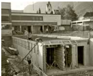
Stand der Bauarbeiten im Juni 1993
