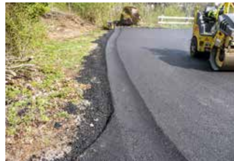
Bei genügend Platz wurde für das Regenwasser eine Asphaltmulde ausgeführt.
