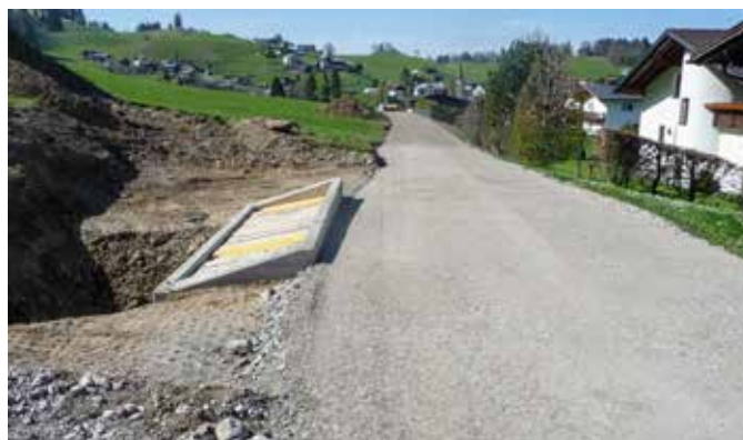
Zwei derartige Schächte werden das zufließende Hochwasser abfangen. Die Einlaufgitter fehlen noch.
