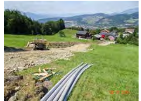
Die Trasse der neuen Wasserleitung nach Rungeletsch.
