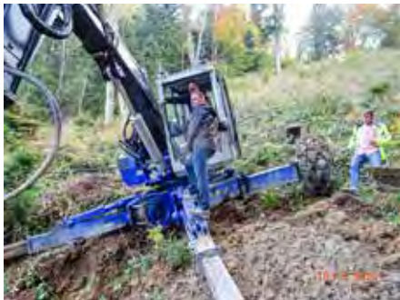
Oberhalb von Rungeletsch musste der Schreißbagger zusätzlich gesichert werden.
