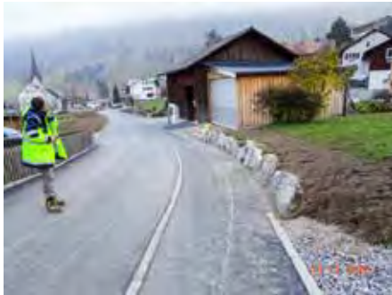
Mitte November wurden die Asphaltierungsarbeiten abgeschlossen.
