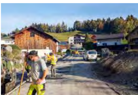
Der Gehsteig im Enderwinkel wird asphaltiert.
