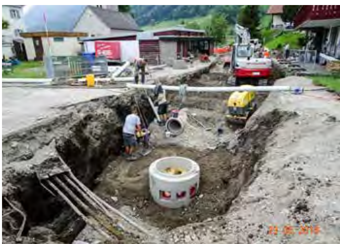
Zuerst wurden die tiefen Leitungen (Schmutz- und Regenwasserkanal) verlegt.
