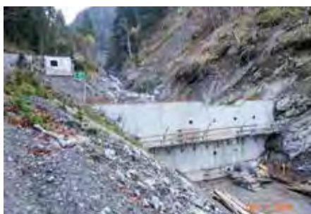
Der Raum hinter der Sperre wurde mit Schotter aus anderen Sperren verfüllt.
