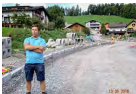
ARGE-Bauleiter Ing. Martin Schöch. Mitte September wurden die Leistensteine verlegt.
