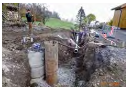
Das senkrechte Stahlrohr wird zum Absenken des Grundwassers benötigt.
