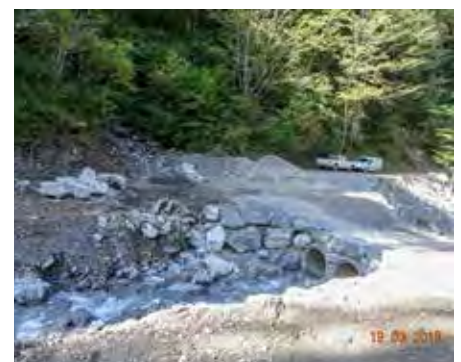
Statt der Holzbrücke wurde eine Rohrfurt errichtet.
