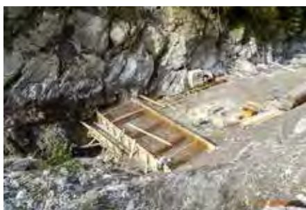
Das Fundament der ersten Talsperre wurde betoniert.
