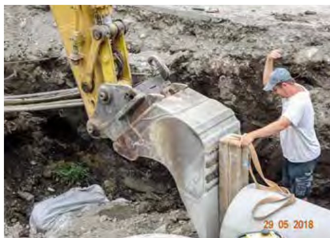
Der Bagger drückt das Stahlbetonrohr in die Dichtung des bereits verlegten Rohres.
