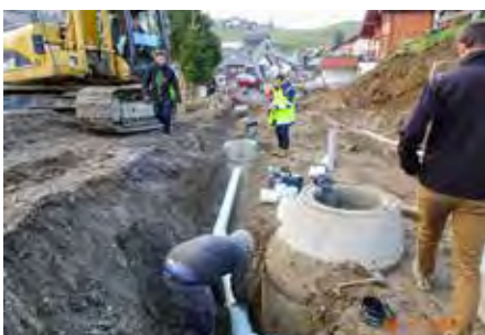
Hier erfolgt der Anschluss eines Straßeneinlaufschachtes an den Regenwasserkanal.
