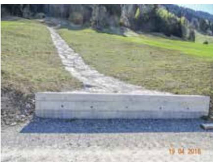
Das Einlaufbauwerk soll das Hochwasser aufnehmen. Das Sohlpflaster verhindert ein Erodieren der Zulaufmulde.
