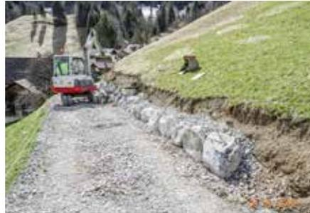
Sicherung von Steilböschungen im Gleilebühel mit einer Trockensteinmauer.
