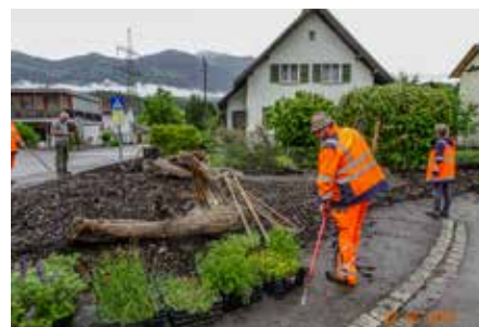
Pro Quadratmeter wurde eine Initialpflanze gesetzt, dazwischen wurde eine spezielle Blumenmischung gesät.
