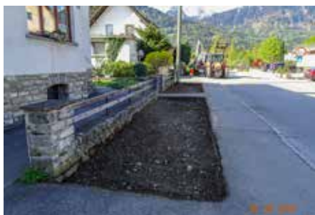
Für die Blumenwiese musste der Humus entfernt und durch Schotter ersetzt werden.
