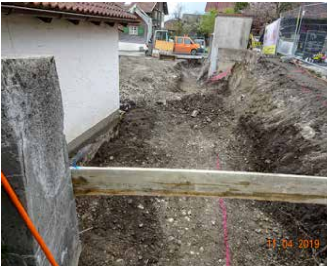
Der Zugang für Fußgänger vom „Am Rain“ wurde zur Gänze abgerissen.
