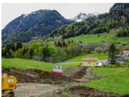
Die letzten Kanalgräben wurden humusiert.
