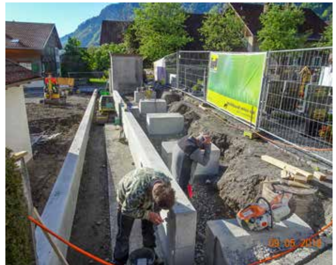
Neben den Mauern für den neuen Fußgängerzugang wurden die Fundamente für die Urnengräber gesetzt.
