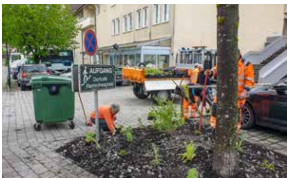
Auch beim Ramschwagplatz entstand eine neue Blühfläche. Die volle Pracht wird sich erst im nächsten Jahr entfalten.
