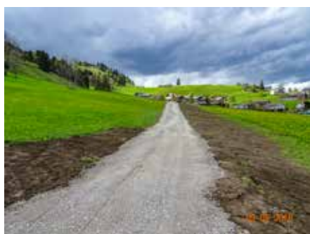
Die „Umfahrungsstraße Muggabill“ wurde auf die ursprüngliche Breite zurückgebaut.
