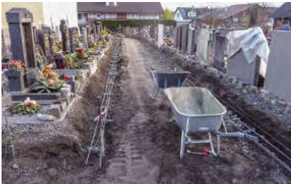
Hier sind die Armierungseisen für den Pflastersaum zu sehen.
