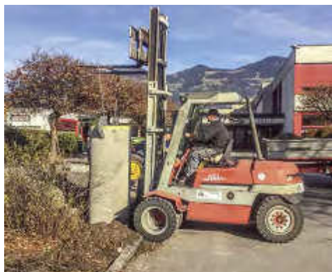
Abgesenkt in das vorbereitete Loch und außen mit Beton verfüllt.
