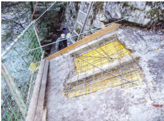
Nach dem Einschalen und Armieren konnte betoniert werden.
