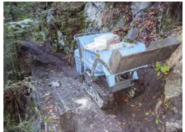
Vorgemischter Beton wurde in Säcken antransportiert.
