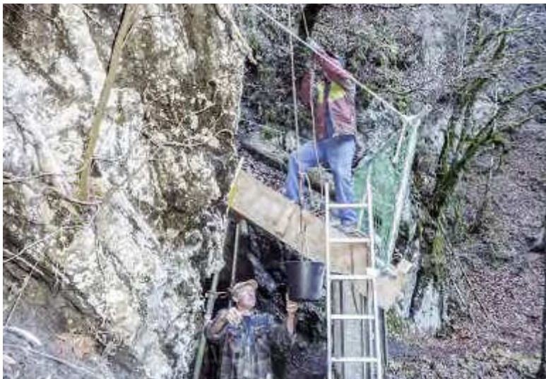
Nach dem Einschalen und Armieren konnte betoniert werden.
