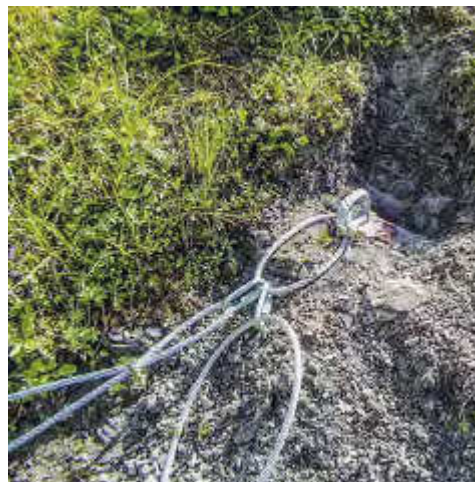
Anschlagpunkt im Fels – ein mit Ankermörtel eingeklebtes Torstahleisen und Einhängeschlaufe
