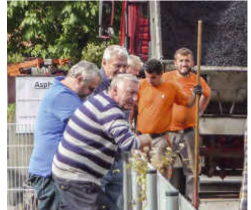
Keine Baustelle ohne Zaungäste; die Asphaltfirma Wilhelm & Mayer, Götzis, wird genau beobachtet.
