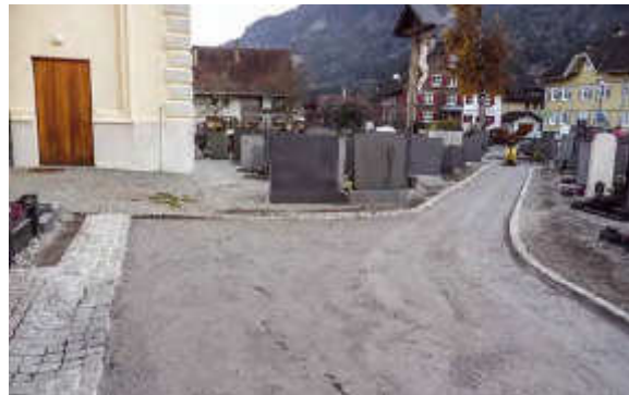
Bereit für den neuen Asphalt
