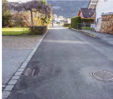
Wiesengrund Oktober 2015, der Fahrkomfort wurde verbessert.
