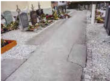
Schäden durch Setzung und Grabbestattungen
