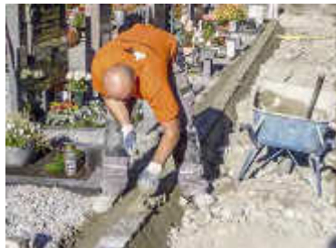
Die alten Pflastersteine wurden wiederverwendet. Die Mörtelverfugung geschah in Handarbeit.
