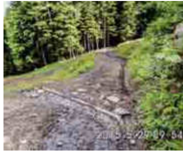
Richtung Nenzinger Berg – eine perfekte Wasserausleitung
