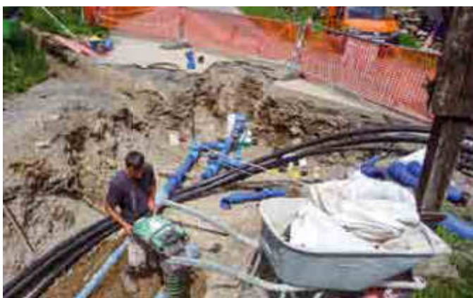
Die Verbindung der Zuleitung vom neuen Hochbehälter ins Ortsnetz wird hergestellt.
