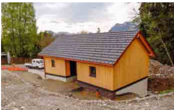
Das neue Drucksteigerungspumpwerk in Muggabill. Das halbe Gebäude ist als Lagerraum für Gurtis konzipiert.
