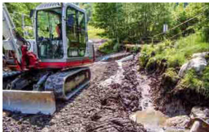
Großer Wasserandrang bei Grabungsarbeiten neben der Wassertrete
