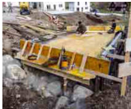
Der Bau kann im Trockenen erfolgen.
