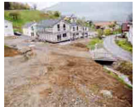
Die Brücke steht, der Bach wurde zurück geleitet.
