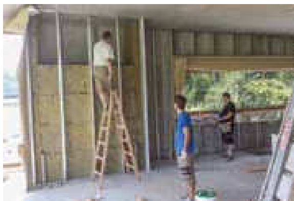
Dämmen der Außenwände
