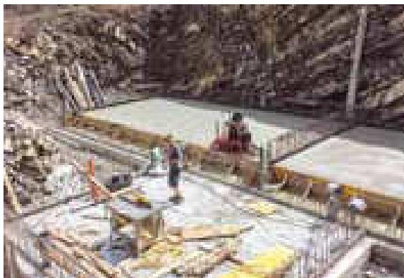
Die frisch betonerte Bodenplatte der beiden Behälterkammern
