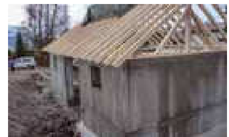
Der Rohbau steht. Heute ein seltener Anblick - das klassische Satteldach
