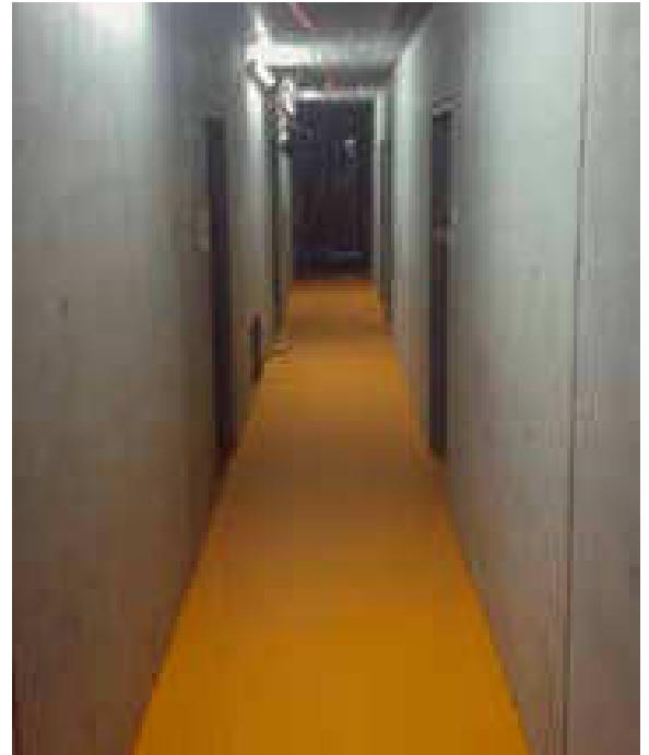
Bodenbeschichtung im Verbindungsgang
