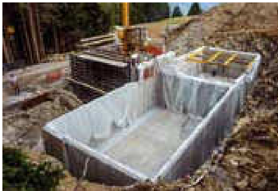
Die Wände der Behälterkammern stehen. Folien schützen den Beton vor zu raschem Austrocknen.
