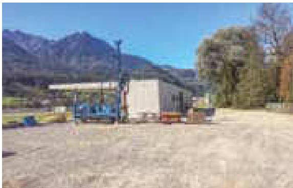
Bohrgerät für den Grundwasserbrunnen
