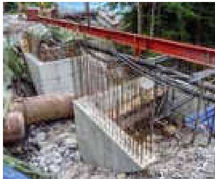
Die neuen Widerlager entstehen.
