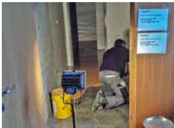
Anbringen der Bodenbeschichtung
