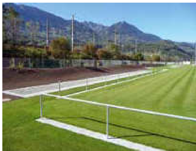
Fertigstellung der Umgebungsarbeiten
