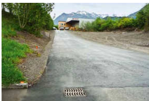
Gewerbegebiet Galina – neue Zufahrtsstraße
