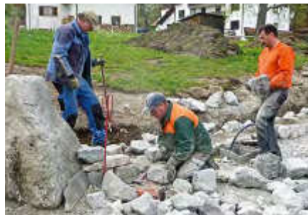
Eine alte, beschwerliche Kunst – der Bau einer Trockensteinmauer
