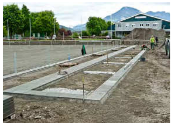
Fundamente für die „alte“ Stahltribüne
