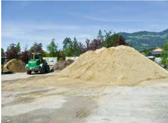
Zirka 150 Tonnen Quarzsand werden dem Humus zugemischt.
