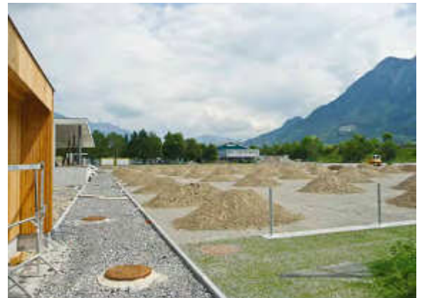
Das Humus-Quarzsandgemisch wurde ausgebracht und ...
