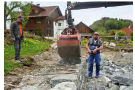
Markus Peßl von unserem Bauhof setzt die schweren Abschlusssteine.
