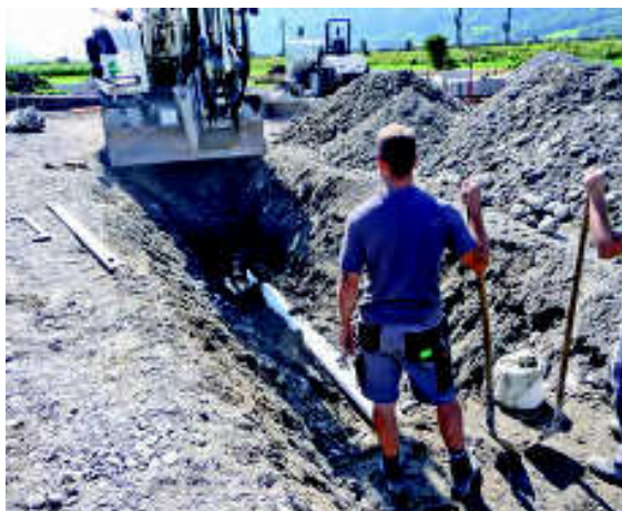
Der Schmutzwasserkanal wird verlängert
