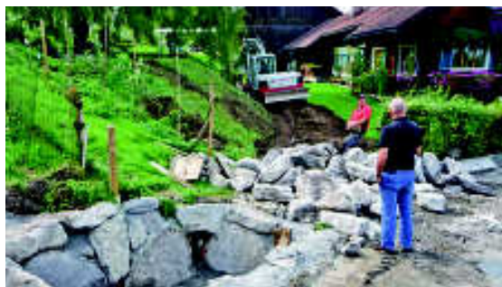
Bau des Schotterfangs
