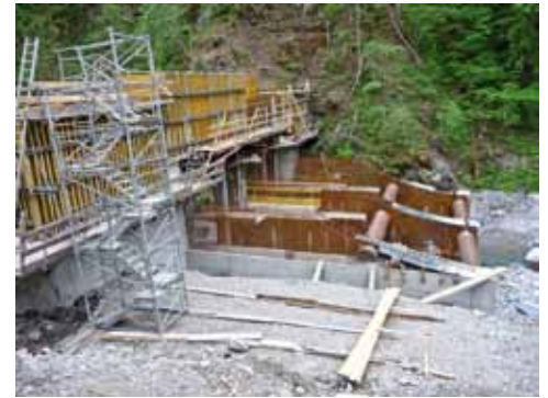
Die Stahlpanzerung schützt den Beton vor dem Geschiebeabrieb
