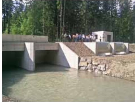
Links die Durchleitung des Dabaladabaches durch ein Rückhaltebecken; Rechts die Klappen für die gesteuerte Flutung dieses Beckens
