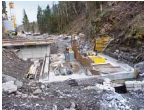
Vom ausladenden Fundament wird man später nichts mehr sehen
