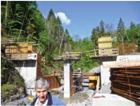
Die Seitenwände und die Mittelstütze werden hochgezogen
