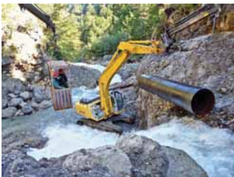
Neuwald-Rutsch – Umleitungsrohre werden am Fels befestigt
