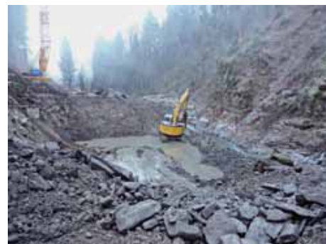
Fundamentaushub für die Rechensperre
