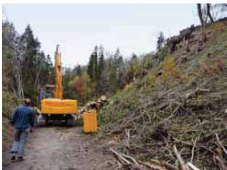
Rechensperre Mengschlucht – Roden des Baufeldes
