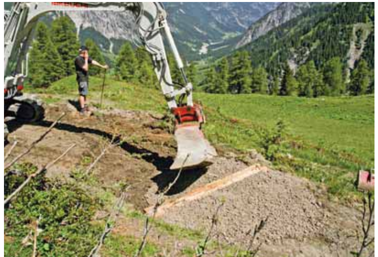
Verbesserung Alpweg Hinterpanül
