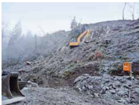
Lockergestein muss abgeräumt werden
