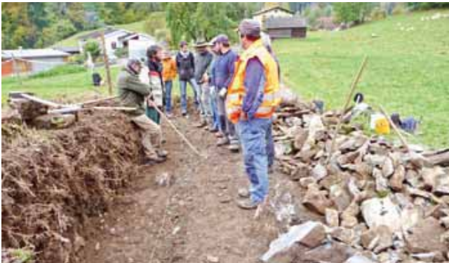
Das alte Mauerwerk wurde zur Gänze abgetragen
