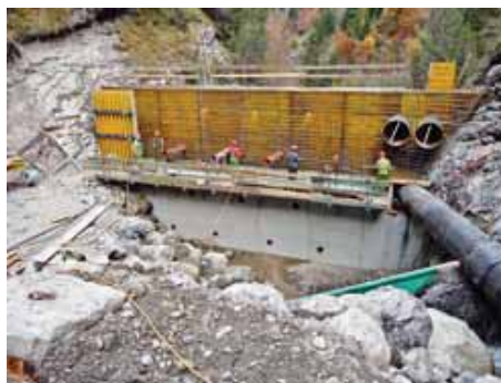
Neuwald-Rutsch – Schalung des 2. Betonierabschnittes
