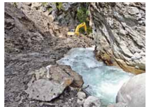
Neuwald-Rutsch – der schwierige Weg zur Baustelle, 2011
