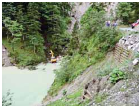
Neuwald-Rutsch – ein Bagger kämpft gegen die Verklauung, 2010
