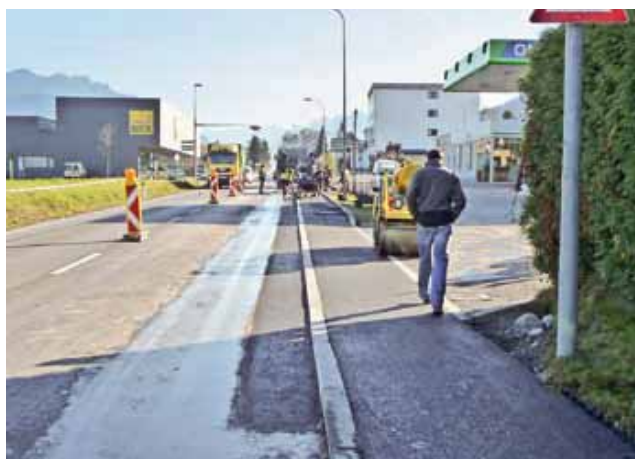
Zum Abschluss die Asphaltierung
