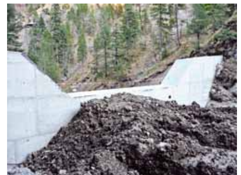
Neuwald-Rutsch – die Hinterfüllung hat begonnen
