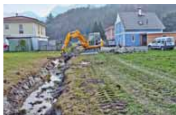
Der Humus wird bis zur vorhandenen Steinmauer abgekratzt
