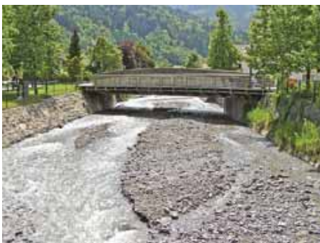
Abgelagertes Geschiebe, mitten im Dorf, 2005
