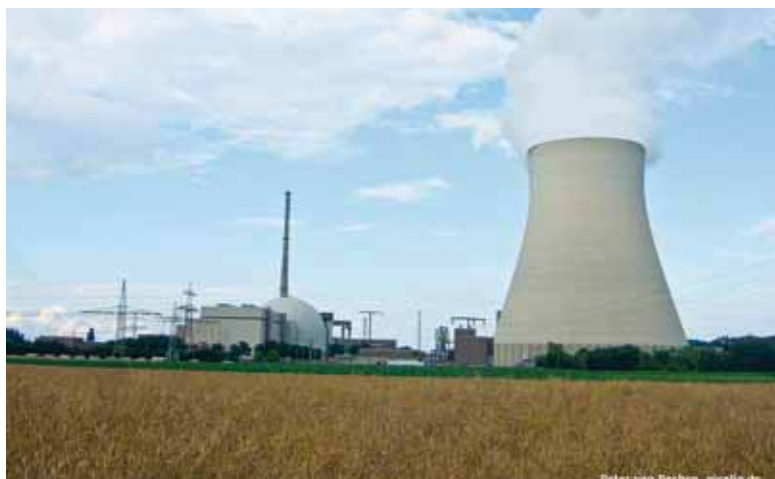
Kernkraftwerk Isar Ohu bei Landshut (D)
