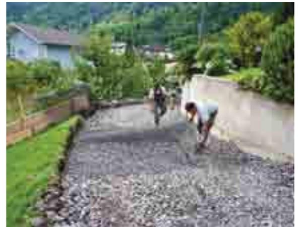
Der Frostkoffer ist eingebracht, das Geotextil wird umgeschlagen.
