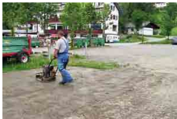
Die nachgebesserten Schotterflächen werden verdichtet
