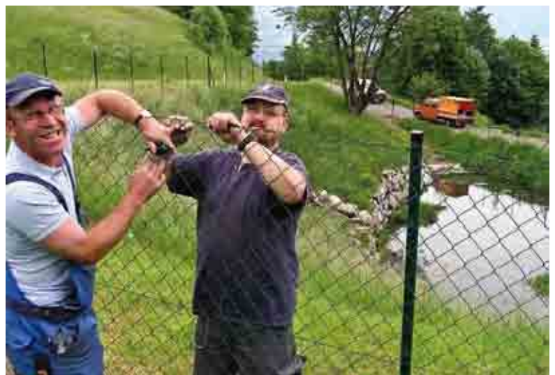
Das Drahtgeflecht bei der Beckenumzäunung wird befestigt
