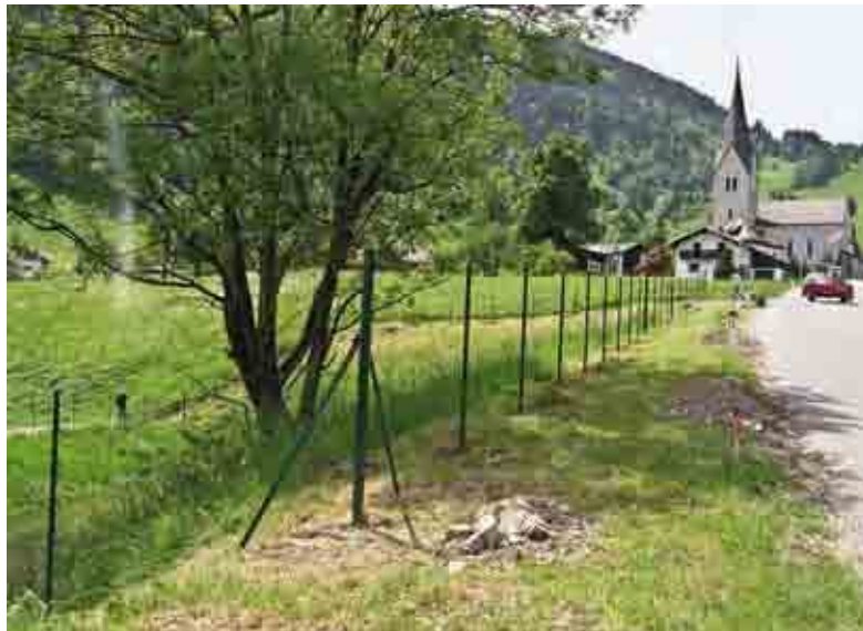
Beckenumzäunung in Gurtis, die Steher sind gesetzt
