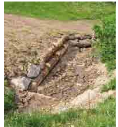
Die fertige Uferstabilisierung
